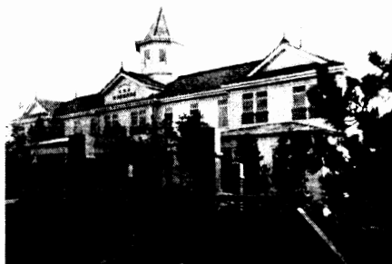
正面から見た南湖院本館
