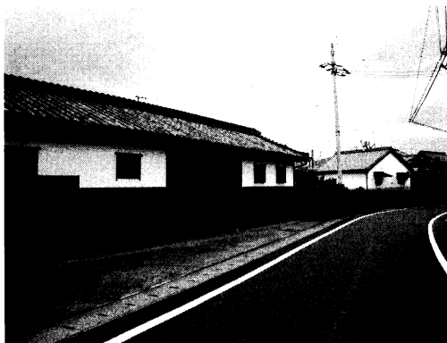
船ヶ谷町の町並みと県道
